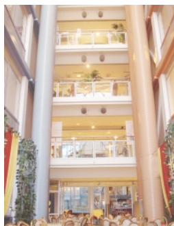
BILD 9. Ventilationskanaler i två av ljusgårdarna på Rambölls Göteborgskontor.
