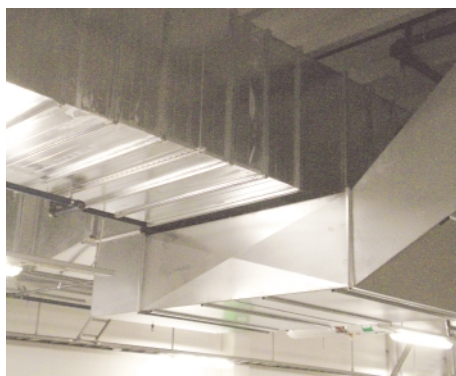
BILD 4. Kryssknäckt kanal.
