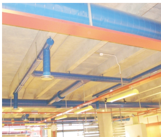
BILD 6. Symmetrisk kanalutformning i kluster där tilluften (som kommer in vid "1") delas upp och passerar genom identiska kanalkomponenter på sin väg till tilluftsdonen.
